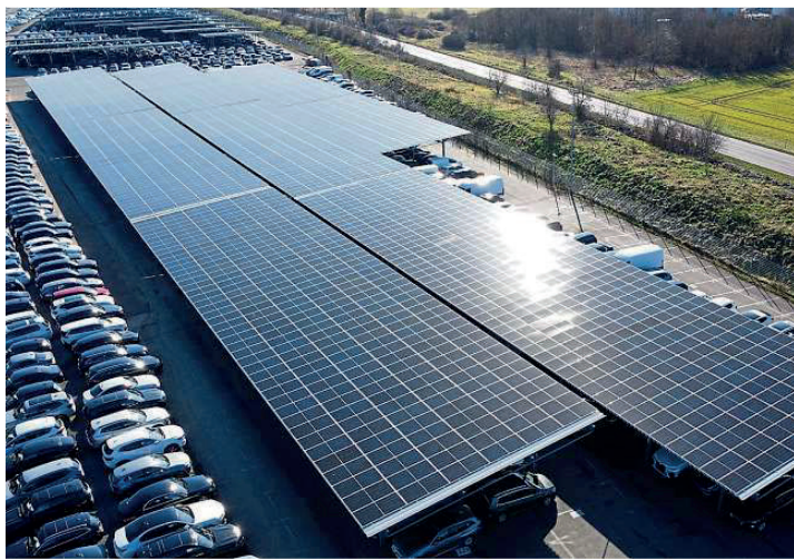
Ein Drittel der geplanten Solar-Carports hat ARS Altmann auf dem Betriebsgelände im Gewerbegebiet Goddelau Süd-West bereits installiert. Rechts ist die B44 zu sehen. Foto: ARS Altmann AG
