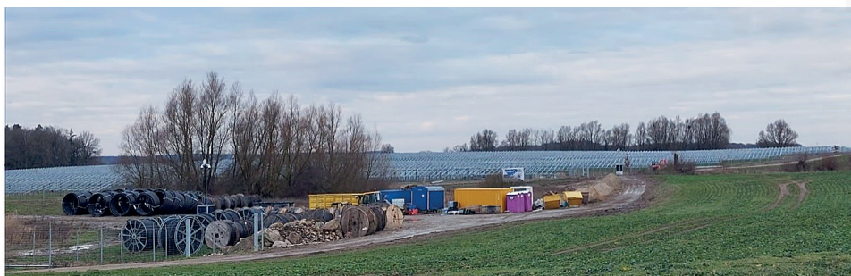
Die Baustelle nahe der B192 bei Neu Schloen fällt auch Autofahrern ins Auge. (Foto: Winfried Wagner)
