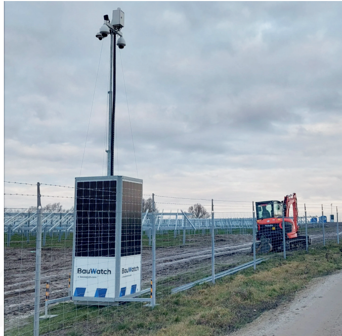
Sicherheit geht vor: Die Baustelle wird mit sogenannten „Watchboxen“ überwacht. (Foto: Winfried Wagner)
