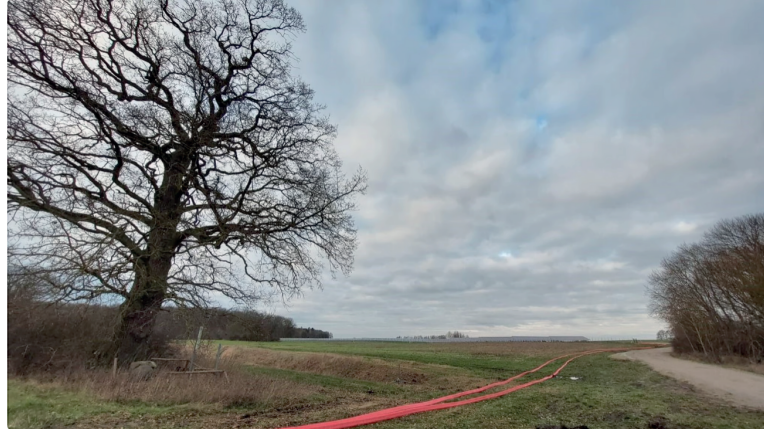
Im Rahmen des Solarpark-Baus finden auch Umweltmaßnahmen statt. (Foto: Winfried Wagner)
